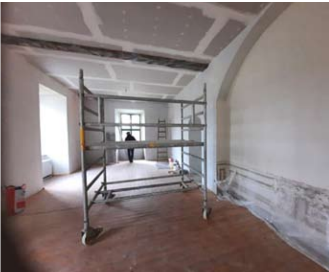
Künstlergarderobe während der Renovierung
