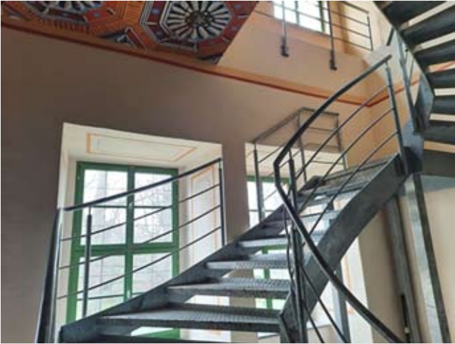
Die benachbarten Fensterlichter waren sparsamer ausgestattet, vermutlich gab es früher einmal eine räumliche Trennung.
